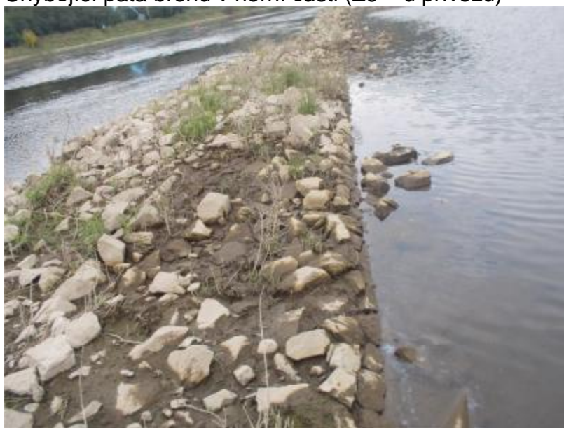
Poškození koruny hráze na dolním konci (D7, Z1, Z2)
